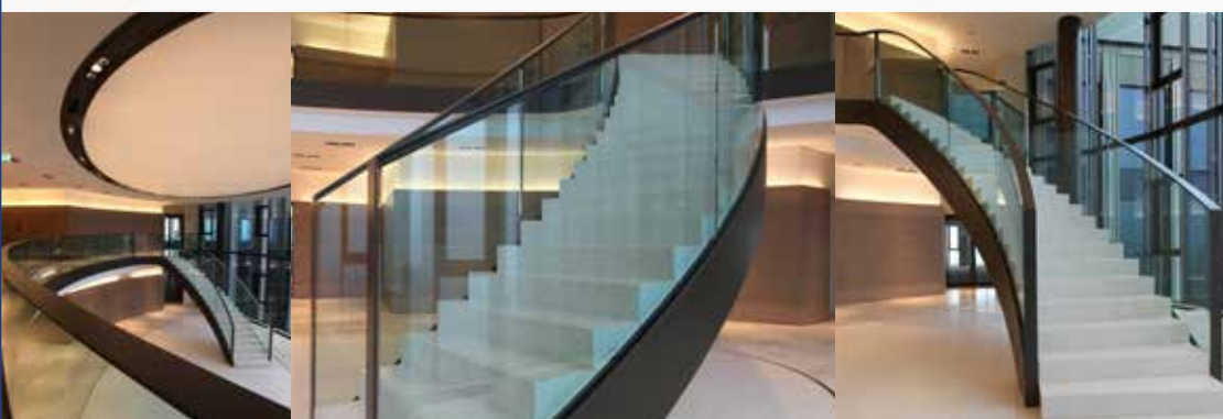
Skyline Tower | Frankfurt | 50 m² | VSG 15.15.4 Weißglas mit Premiumkantenbearbeitung
