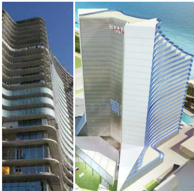
Hier entsteht Luxus pur - Hotel Hyatt Regency, Sochi
